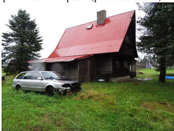
pohled severozápadní (přístavba skladu)
